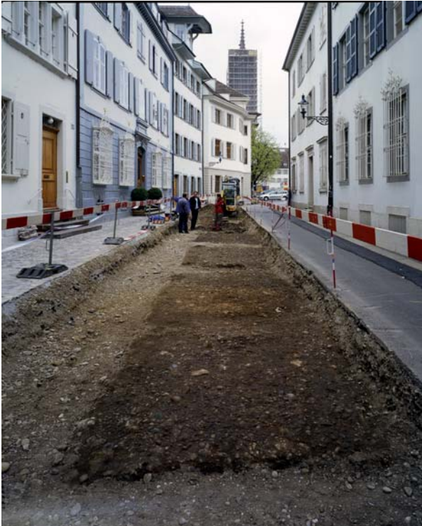
Abb. 1 Die Augustinergasse während der Werkleitungssanierung. – Foto: Philippe Saurbeck.
