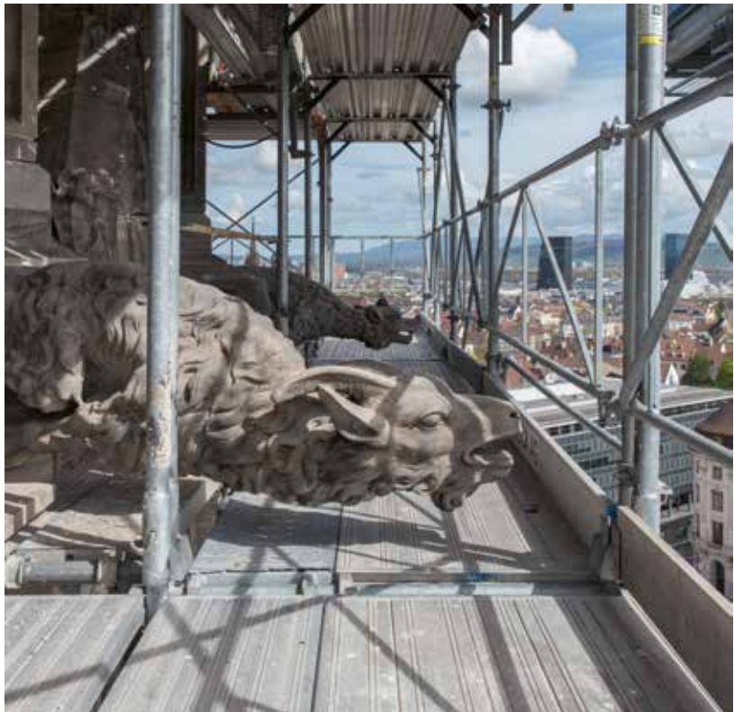
Von hoher bildhauerischer Qualität sind die dem Stil der Hochgotik nachempfundenen Wasserspeier. Sie sind erstaunlich gut erhalten geblieben und haben der Witterung besser getrotzt als viele der Fialen.
