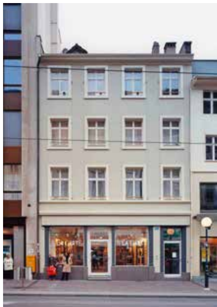
Haus Zum Samariter Sod, Greifengasse 16. Strassenfassade mit Aufstockung von 1876. Die Traufe des 1405 erbauten asymmetrischen Satteldachs lag strassenseitig ursprünglich ein Geschoss tiefer.
