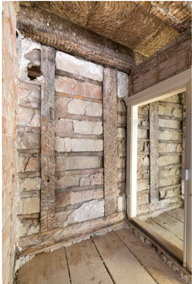
Ständerwand von 1405 im 2. Obergeschoss mit teilweise noch verputzter Ausfachung aus Dachziegelstücken. Der Mörtel weist Abdrücke von Holzoberflächen auf. Daraus lässt sich ableiten, dass gegen eine Holzschalung gemauert wurde. Auf dem bauzeitlichen Unterboden sind Reste des Mörtelstrichs zu erkennen.
