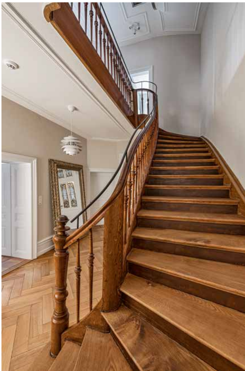
Das bauzeitliche Geländer des Treppenaufgangs ist sehr niedrig und wurde mit einer dünnen Metallstange diskret ertüchtigt. Sie begleitet den Handlauf harmonisch auf dem gesamten Verlauf nach oben und ist dennoch als modernes Element klar erkennbar.
