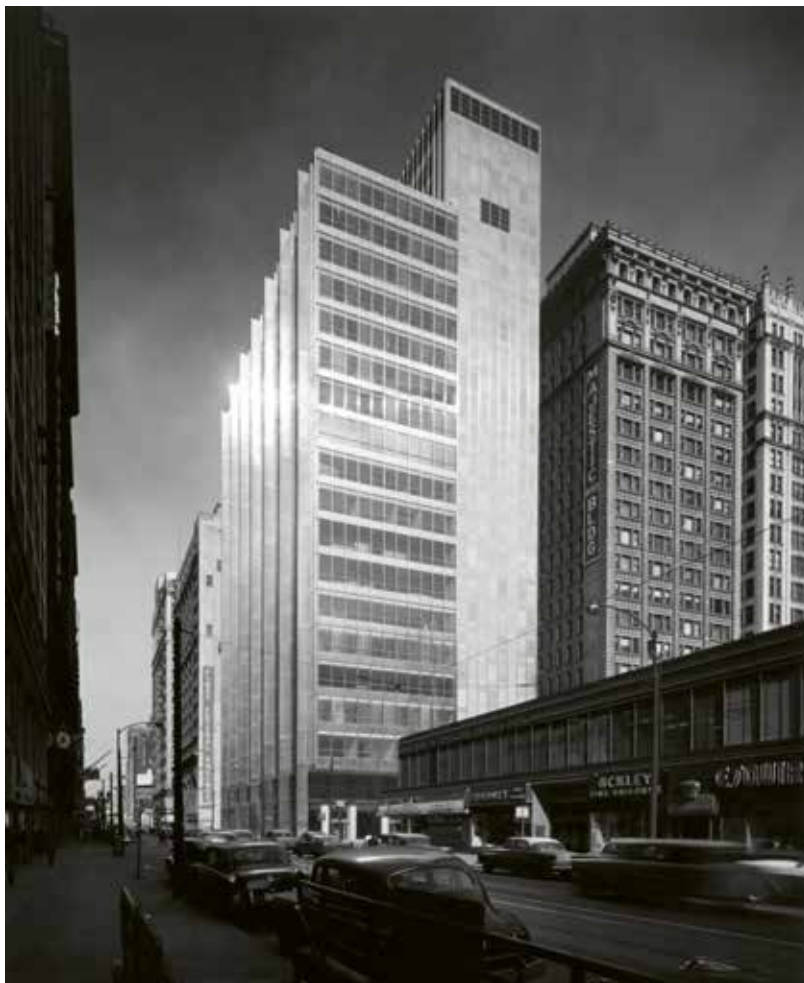
Walter Netsch und Bruce Graham bei Skidmore, Owings & Merrill (SOM), Inland Steel Building , Chicago, 1956–1958. Foto 1958. Bei der ab 2008 erfolgten Ertüchtigung und Renovation des Gebäudes durch SOM wurde lediglich die Isolierverglasung der Curtain Wall ausgetauscht. Dank einer umfassenden Erneuerung der Haustechnik wird das mittlerweile als Office Hotel genutzte Gebäude heutigen Komfort- und Nachhaltigkeitsansprüchen gerecht.
