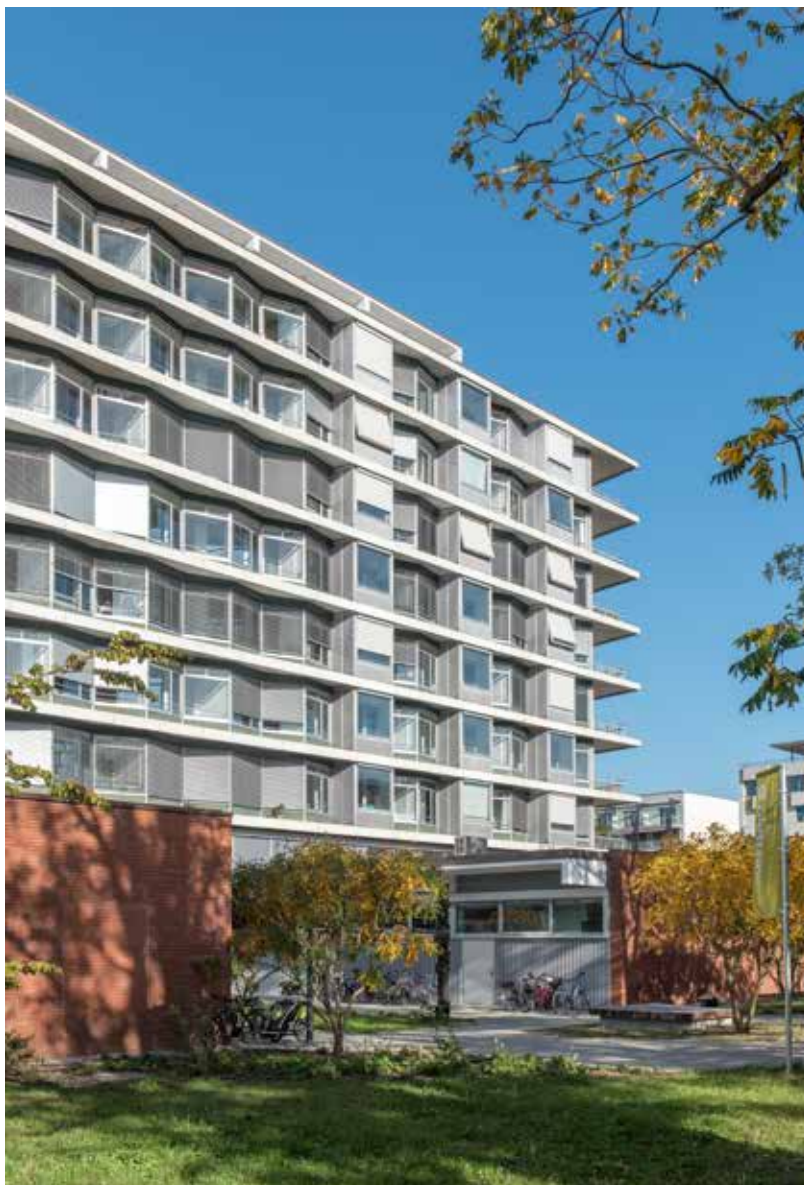
Die Südwestseite mit den eingeschossigen Vorbauten. Die gefalteten Fassadenbereiche prägen zusammen mit den dynamisch auskragenden Balkonen an den Stirnseiten und dem Flugdach auch nach der Umnutzung das Erscheinungsbild des imposanten, umgebungsprägenden Baus.
