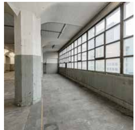
Bau 26, 2. Obergeschoss. Die Pilzdeckenkonstruktion ermöglicht unterzugslose Decken, die bis an den Gebäuderand auskragen. Die Fassaden sind von der Konstruktion entkoppelt und von Traglasten befreit.
