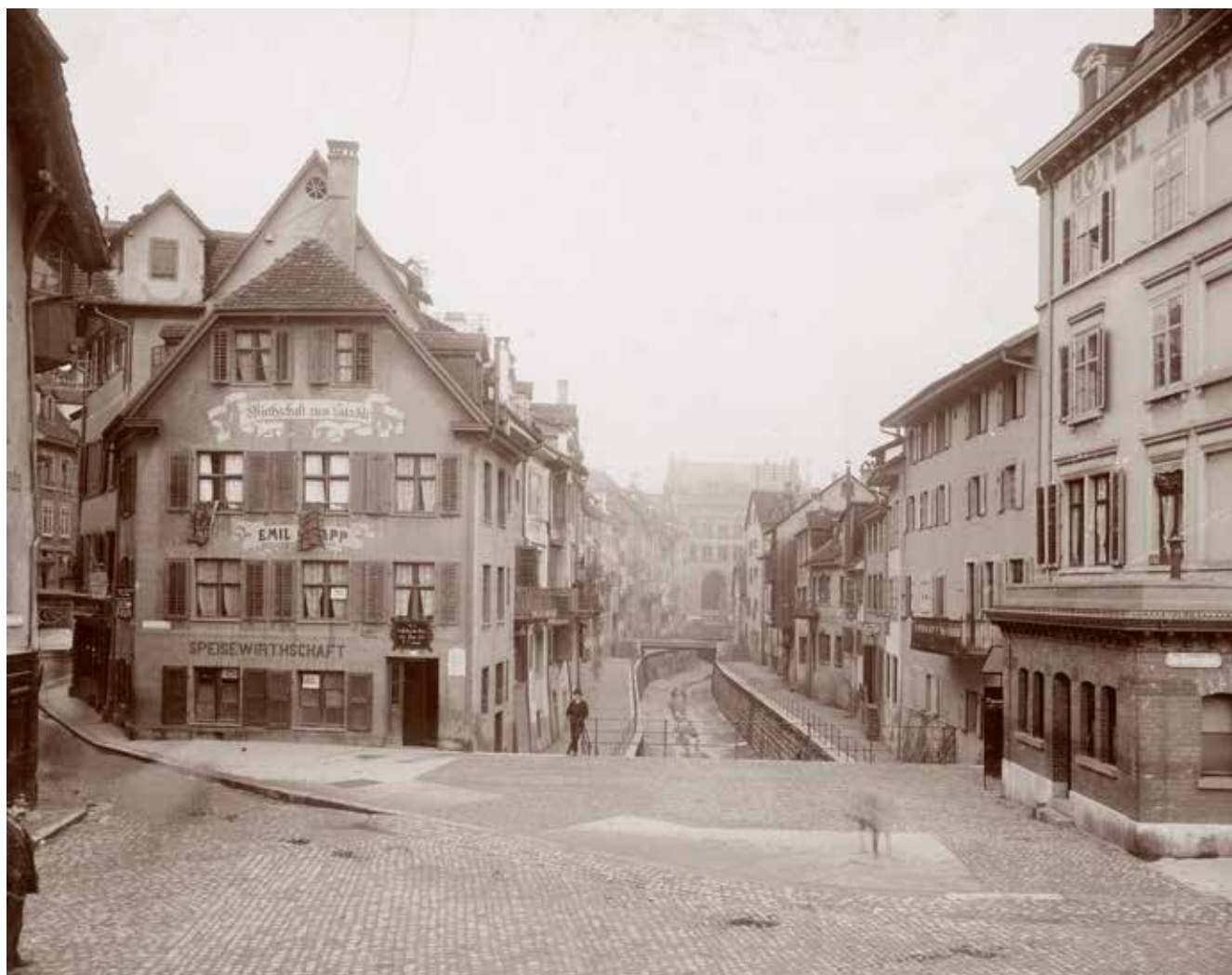
5 – Der Birsig Ende des 19. Jahrhunderts, nach der Korrektion 1887/88 und vor der Überwölbung und dem Bau der Falknerstrasse 1899/1900. Links das Haus Zum Sterneneck mit der Wirtschaft Zum Stöckli (Barfüsserplatz 1), dahinter teilweise sichtbar die Häuser Gerbergasse 81 und 79, in der Flucht des Birsigs die Hauptpost. Statt der Abtritte haben einige Häuser nun Balkone zum Birsig erhalten.
