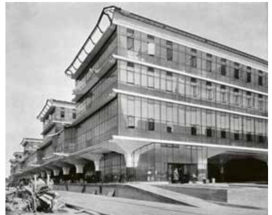
Der Ciba-Bau 26 steht v. a. mit seiner Pilsdeckenkonstruktion in der Tradition moderner, längst zu Ikonen gewordener Industriebauten, etwa der Van Nelle-Fabrik in Rotterdam (1925–1931, Brinkman & Van der Vlugt mit Mart Stam; oben) oder des Fabrikgebäudes D10 des Pharmaunternehmens Boots in Beeston/Nottingham, England (1930–1932, Owen Williams; rechts).
