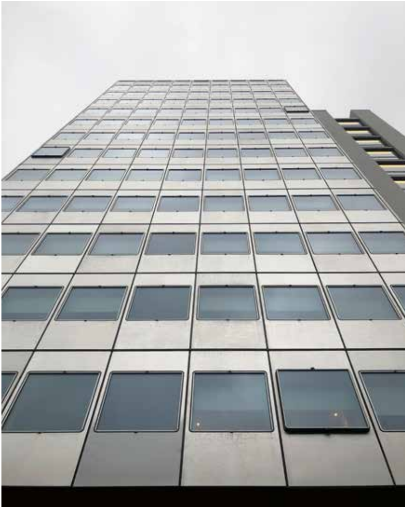
Die patinierten Aluminiuelemente der Vorhangfassade des Commerzbank-Hochhauses vermitteln heute den historischen und baukulturellen Wert des Gebäudes. Zu erkennen sind die Ausstellfenster, die eine natürliche Lüftung ermöglichen.
