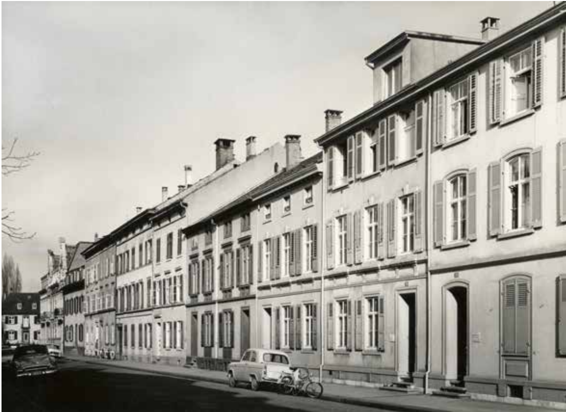
Intakte Erstbebauung an der Socinstrasse. Foto 1958.
