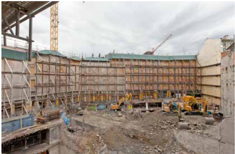
2 – Rückseitige Ansicht der Fassaden nach Sicherungsmassnahmen und Auskernung des Gebäudes: in der Mitte die abgewinkelte Fassade von 1904/05 und 1909. Rechts die Fassade von 1932/33 an der Eisengasse; links diejenige der Erweiterung von 1975/76 am Marktplatz. Ganz rechts im Bild die Stützmauer zum Martinskirchplatz.
