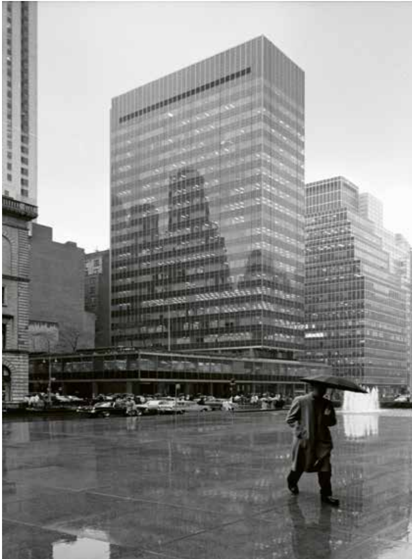
Gordon Bunshaft und Natalie de Blois bei Skidmore, Owings & Merrill (SOM), Lever House , New York, 1950–1952. Foto 1964. Nachdem über die Jahre hinweg fast die Hälfte der Verglasungen ausgetauscht worden war, erfolgte 2001 der Komplettersatz der Metall-Glas-Fassade dieses ikonischen Gebäudes durch eine dem Original weitgehend nachgebildete Neukonstruktion. Seit 2022 kümmert sich SOM um die umfangreiche Restaurierung des Lever House .
