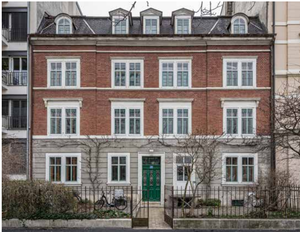
Das 1889 errichtete Wohnhaus Klingelbergstrasse 77 ist ein besonders qualitätvolles Beispiel für die damals beliebte Verwendung von Sichtbackstein. Es zeigt sich in äusserst gepflegter bauzeitlicher Gestalt.
