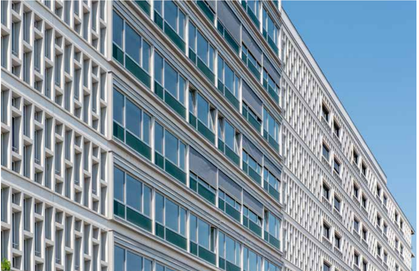
Nordostfassade nach Abschluss der Umbauarbeiten. Die vorgefertigten Betonelemente aus der Bauzeit wurden lediglich gereinigt und wo nötig repariert, der Metall-Glas-Bereich musste hingegen komplett erneuert werden – samt Wiederherstellung des historischen Erscheinungsbilds.
