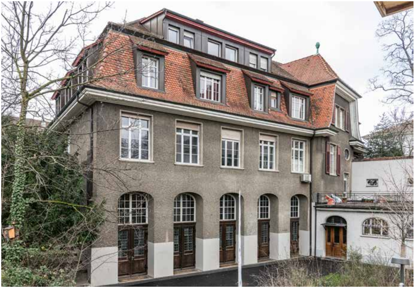
Das Schulhaus Nonnenweg 36 wurde 1912/13 vom namhaften Architekturbüro La Roche & Stähelin für die Basler Mission errichtet. An den Fenstern der Rückseite sind die Turnhalle und darüber die Schulzimmer ablesbar.
