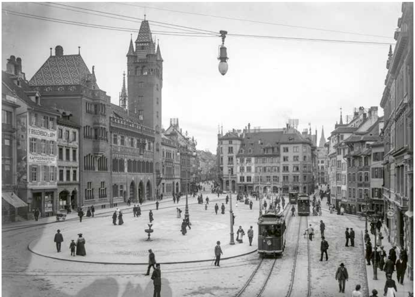
Marktplatz, um 1905. Mit den elektrischen Lampen kam das aus den Tagen der Öllaternen bekannte System der Aufhängung über der Strassenmitte wieder zur Anwendung. Zusätzlich befanden sich auf der Trottoirinsel des Marktplatzes zwei monumentale Masten mit elektrischen Laternen. Die tropfenförmigen Glasballons wurden zu Beginn des 20. Jahrhunderts durch kurze offene Zylinder ersetzt.
