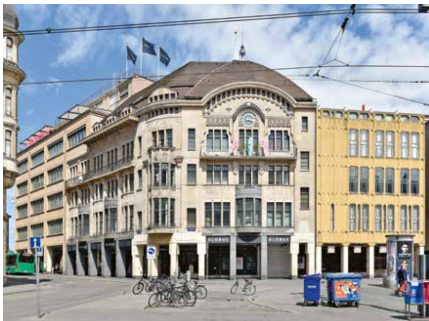
1 – Die verschiedenen Gebäudeteile des Globus: in der Mitte das 1904/05 ursprünglich unter dem Namen Brann errichtete Warenhaus (Romang & Bernoulli). Links in der Eisengasse die erste Erweiterung von 1909 durch die Magazine zum Globus AG im gleichen Stil (Bernoulli, Wenk & Cie/Karl August Burckhardt). Zuhinterst in der Eisengasse der Erweiterungsbau von 1932/33 (Suter & Burckhardt), rechts im Bild die letzte Erweiterung von 1975/76 am Marktplatz (Suter & Suter). Zwischen dem ältesten und dem jüngsten Gebäudeteil stand das untersuchte Brandmauerfragment.
